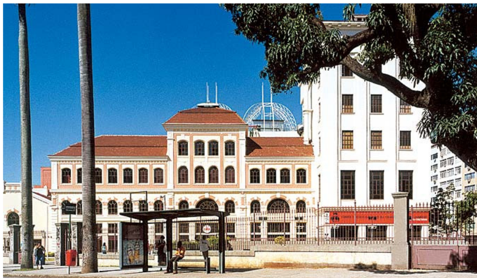
Os dois blocos, de épocas distintas, tiveram as fachadas recuperadas
