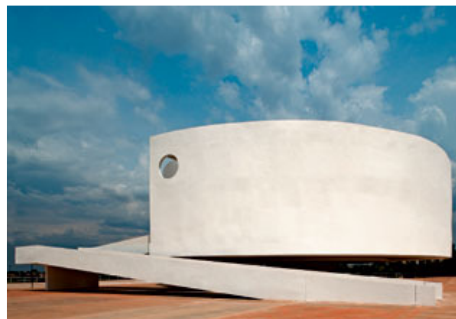
A rampa do museu esconde parte do esforço estrutural do pilar central
